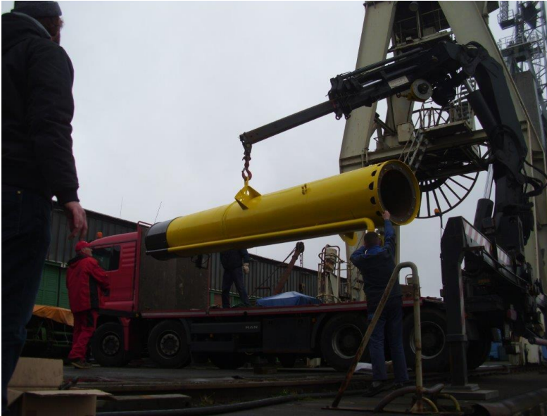
Der neue Schornstein wird angeliefert
