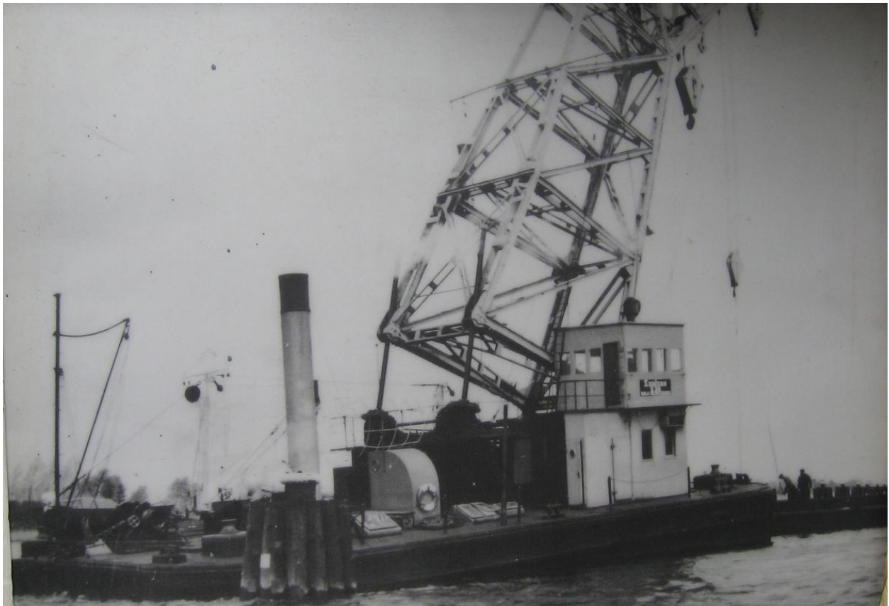
Der Schwimmkran beim Dalbenziehen in einer Weiche - 1961
