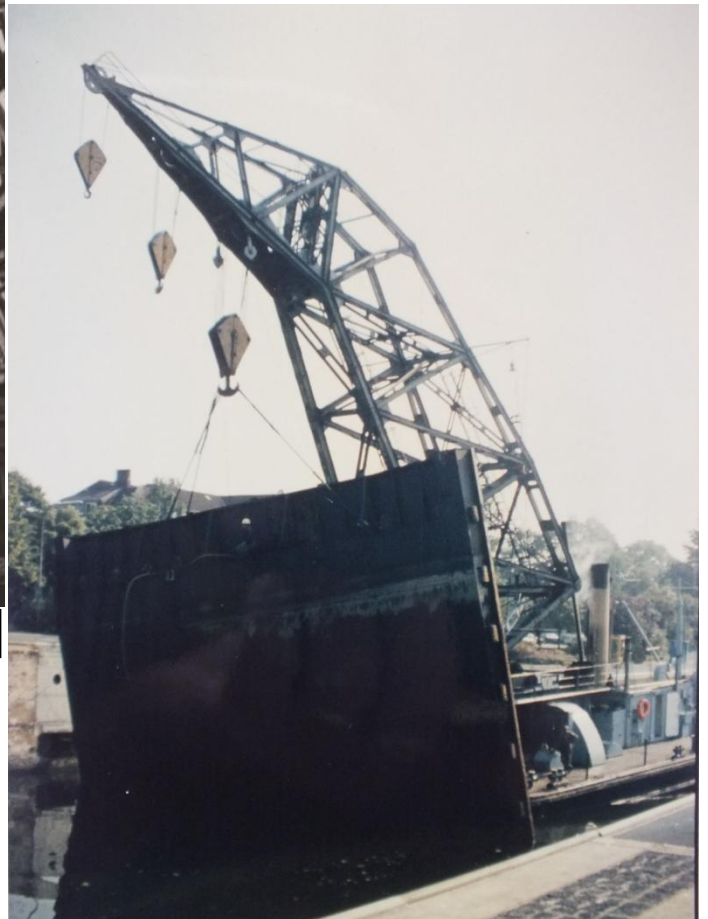
MdA Saatsee beim Heben eines Schleusentores
