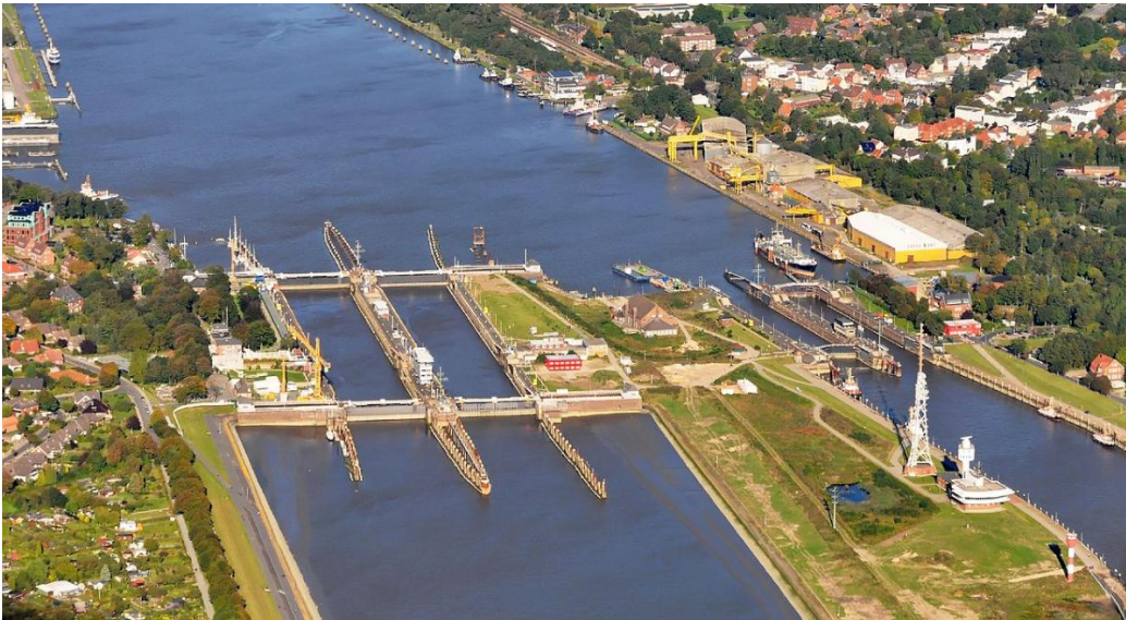
Wikipedia: Schleusenanlagen in Brunsbüttel
