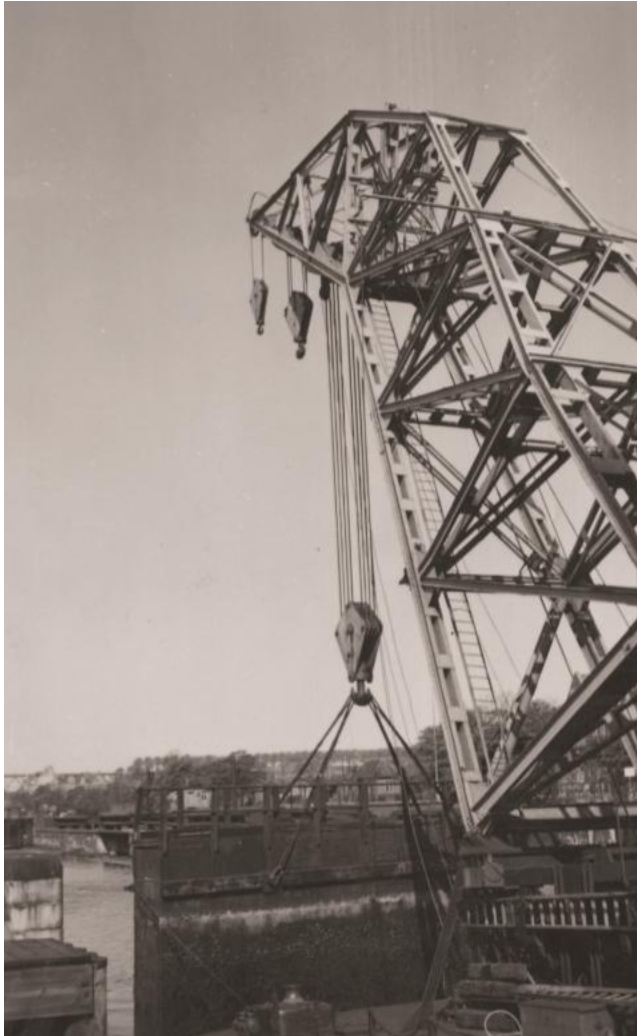
Modellbauer Saatsee beim Heben eines Schleusentores
