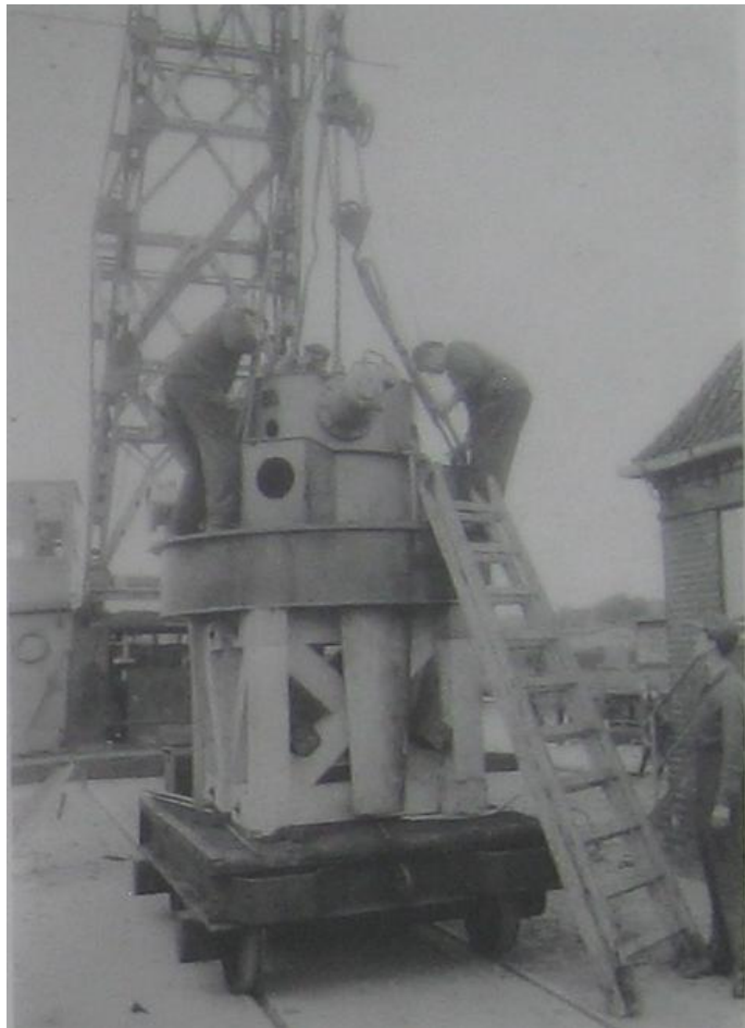
Werftarbeiter schlagen einen Voith-Schneider-Propeller für den Einbau in eine Fähre an.
