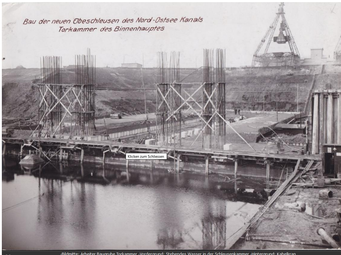
-Bildmitte: Arbeiter Baugrube Torkammer -Vordergrund: Stehendes Wasser in der Schleusenammer -Hintergrund: Kabelkran
