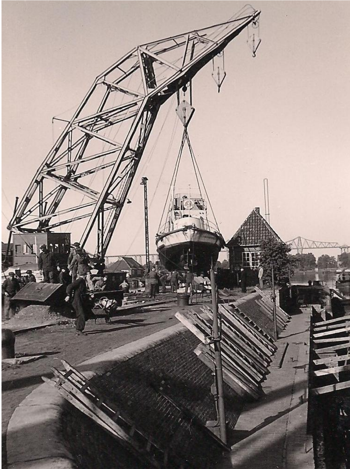
Das havarierte Rettungsboot "Rickmer Bock" wird am Kai der Staatswerft aus dem Wasser gehoben und auf Holzpallen gesetzt.
